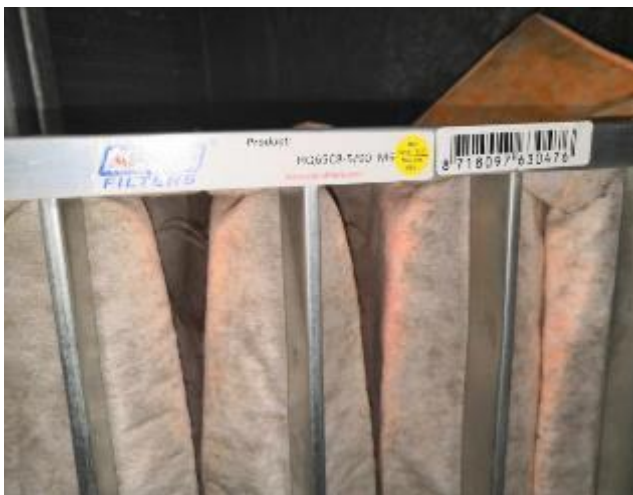
Kuva 1. Tuloilmasuodattimet.
