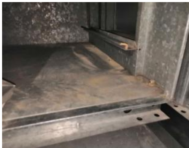
Kuva 2. Siitepölyä suodatinkammion pohjalla.
