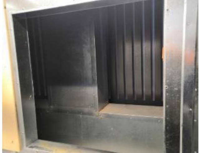
Kuva 2. Vanhan osan IV-konehuoneen raitisilmasäleikkö.
