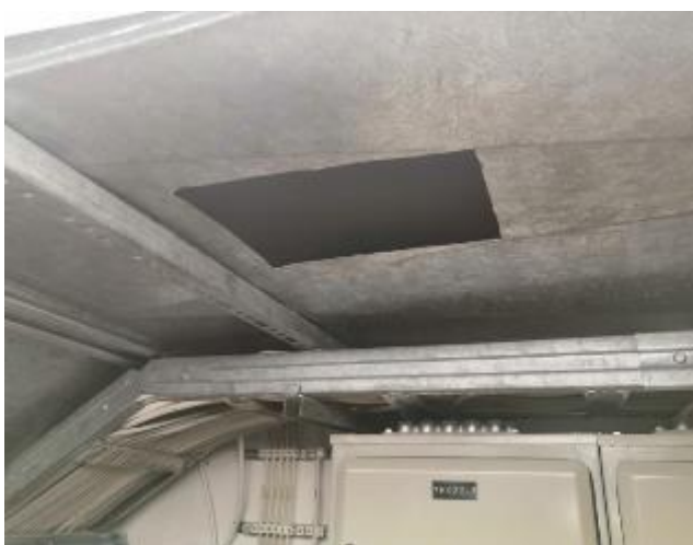
Kuva 15. Poistokanavan 2 tarkastusluukku.
