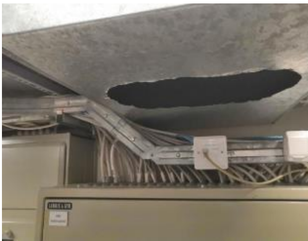
Kuva 13. Poistokanavan 1 tarkastusluukku.
