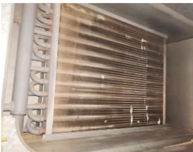
Kuva 25. Tuloilman lämmityspatteri.
