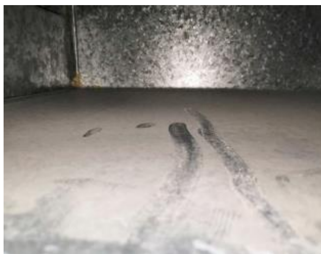
Kuva 16. Pölyä poistokanavassa 2.
