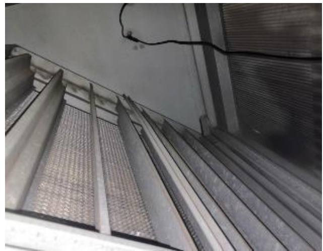
Kuva 8. Tuloilmasuodattimet.
