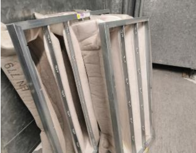
Kuva 19. Poistoilmasuodattimet.
