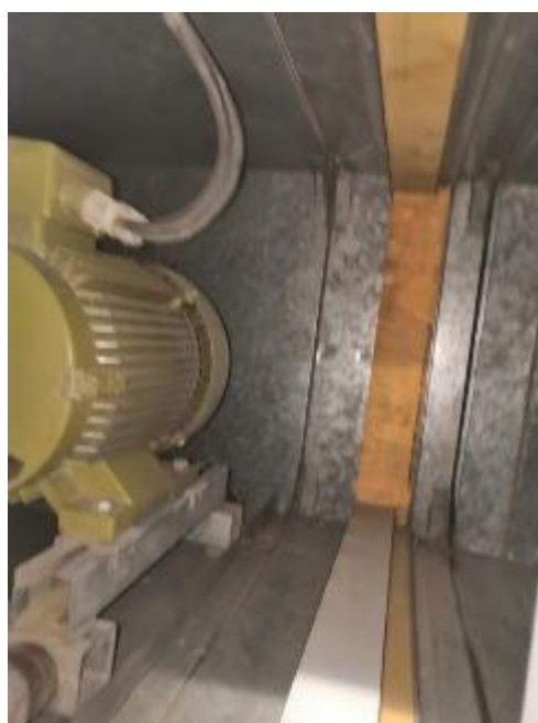
Kuva 18. Puulistoilla korjattu poistoilmasuodatinten kiinnityskehys
