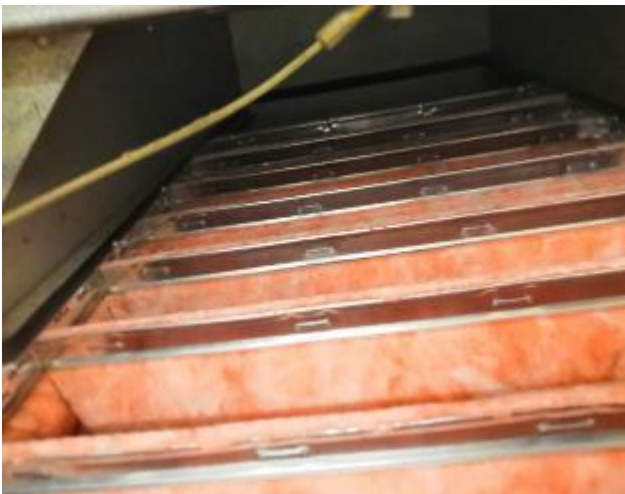
Kuva 35. Poistoilmasuodattimet.
