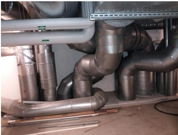
Ilmanvaihtokanavistoa iv-konehuoneessa.
